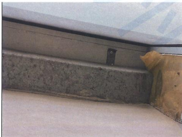
图 4-49 门诊住院大楼防火构造检查情况 1
