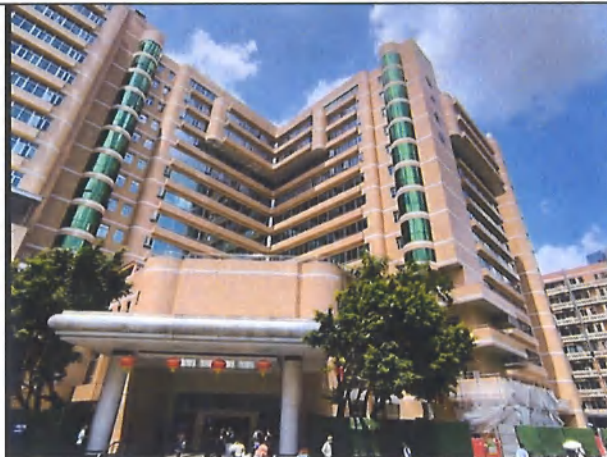
图 1-7 东 1 号楼外立面情况
