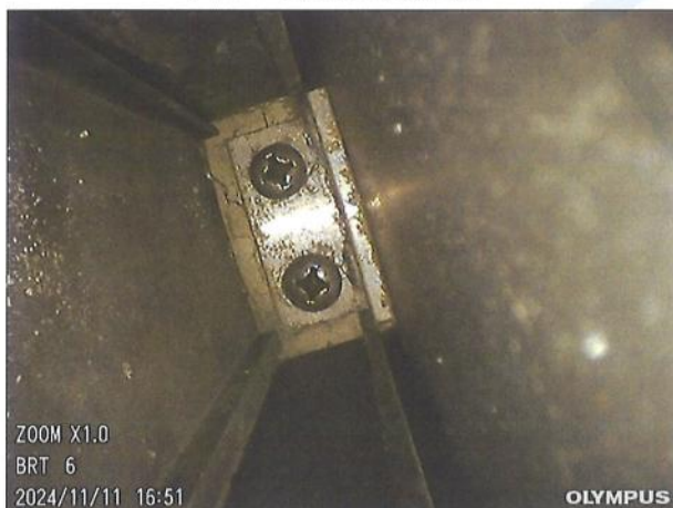
图 5-7 梁柱连接情况 3
