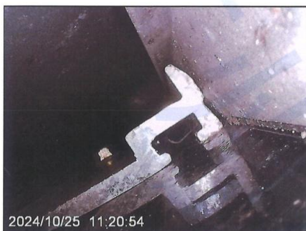
图 4-33 压板与玻璃之间未设置胶条衬垫
