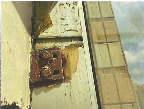
图 4-17 门诊住院大楼检查情况
