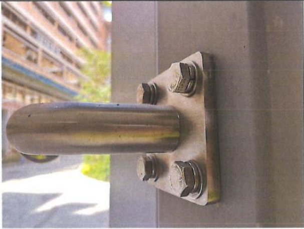
图 6-12 职工餐厅底座与钢立柱连接情况
