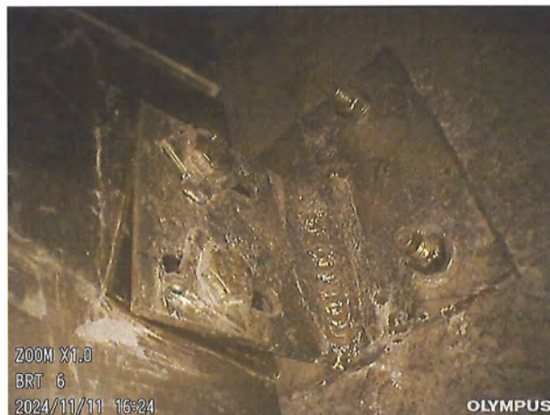
图 5-11 立柱与主体结构连接情况 3
