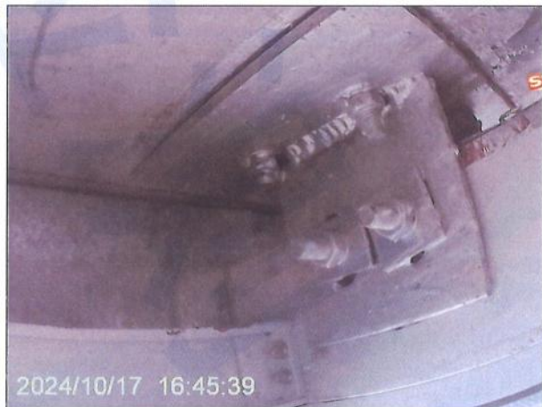
图 4-18 办公楼检查情况
