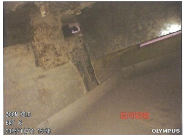
图 5-25 未设置防火构造 2
