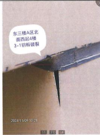
图 10-2 铝板破损
