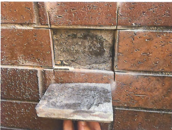
图8-90 粘结层与找平层界面为主断开
