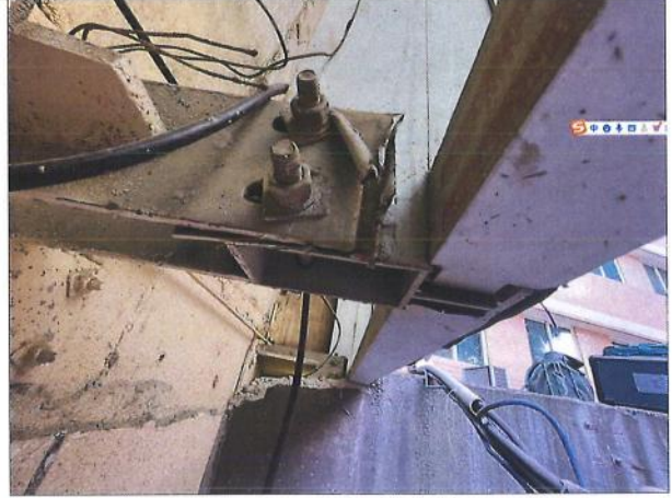
图 4-20 东 3 号楼检查情况
