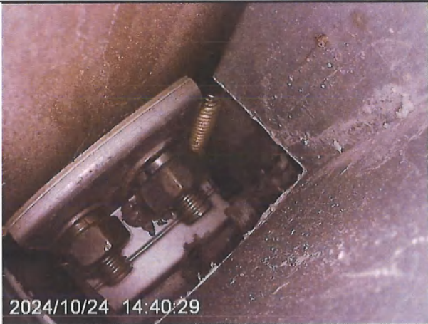
图 4-11 东 3 号楼检查情况
