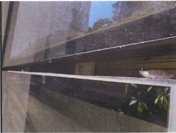
图 5-17 玻璃底部无托条
