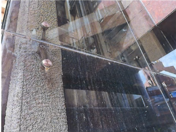
图6-5 门诊住院大楼正门南北侧电梯检查情况1
