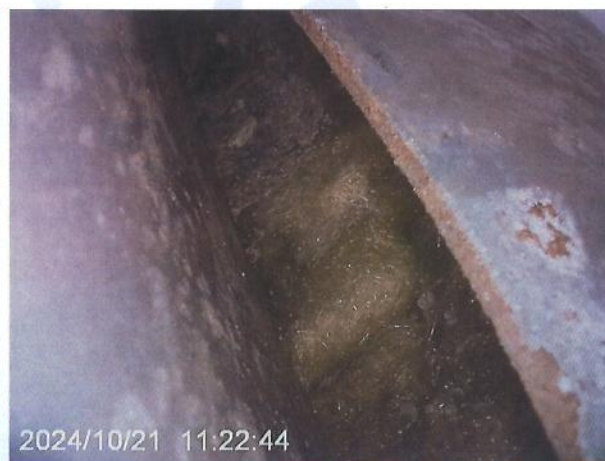
图 4-52 门诊住院大楼防火棉检查情况
