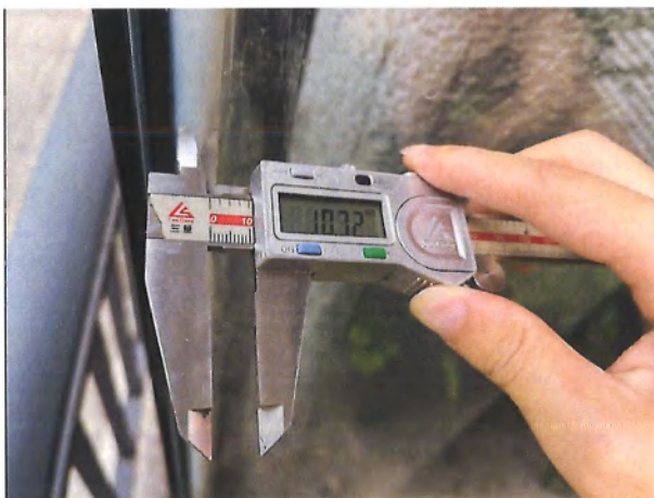
图6-19 玻璃之间的空隙宽度测量1
