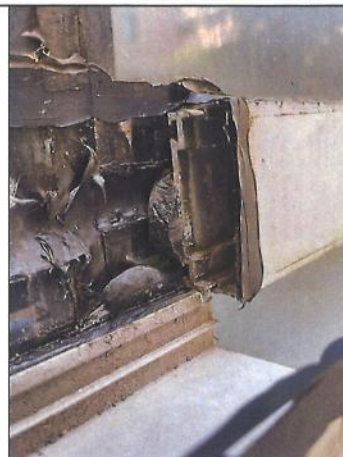
图 4-32 压板检查情况
