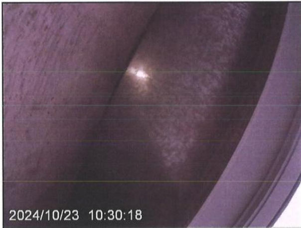
图 4-56 办公楼防火板检查情况 2
