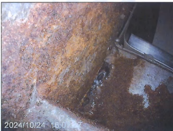
图 7-6 梁柱连接焊缝检查情况 2
