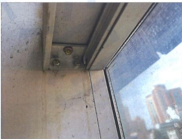
图 4-10 东 2 号楼检查情况
