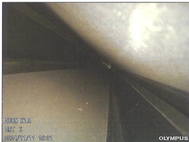
图 5-3 横梁内壁检测情况 1
