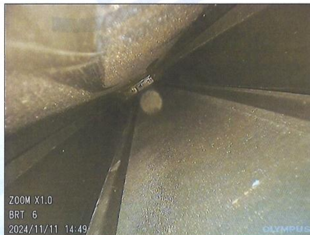
图 5-4 横梁内壁检测情况 2
