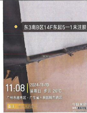
图 10-3 铝板漏注密封胶
