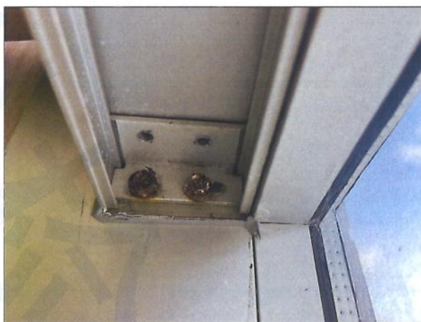
图 4-8 办公楼检查情况
