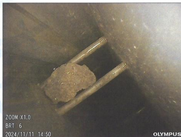
图 5-2 立柱内壁检测情况 2
