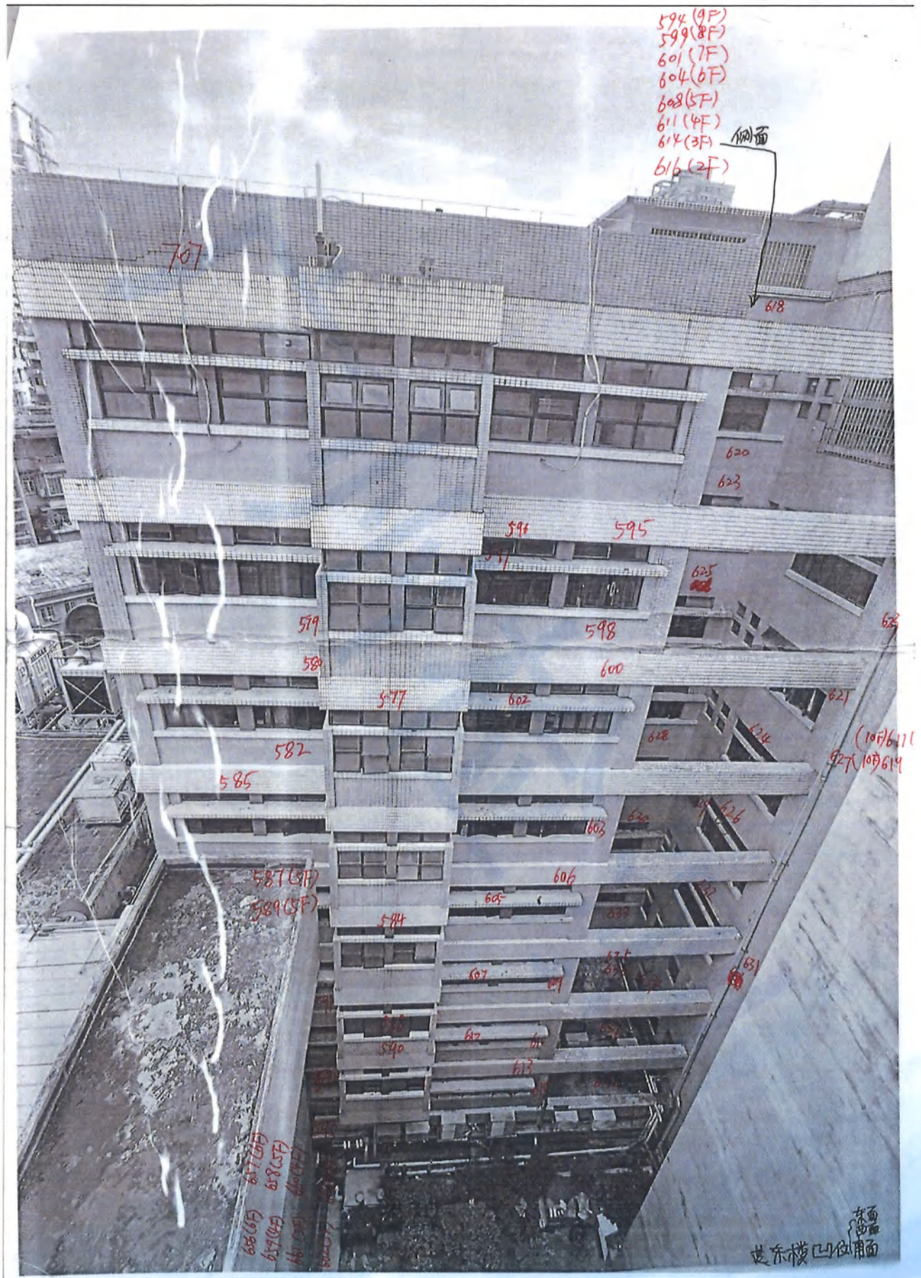
图8-19 英东楼东面4瓷砖缺陷位置示意图
