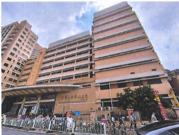
图 1-3 英东楼外立面情况
