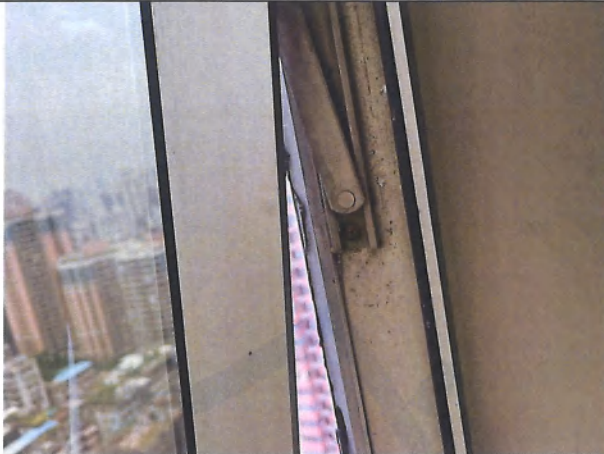
图 4-45 铰链固定螺钉锈蚀
