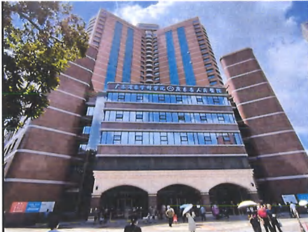
图 1-1 门诊住院大楼外立面情况
