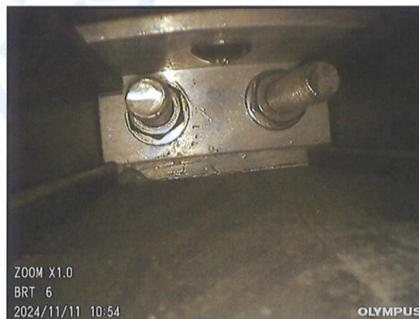
图 5-8 梁柱连接情况 4
