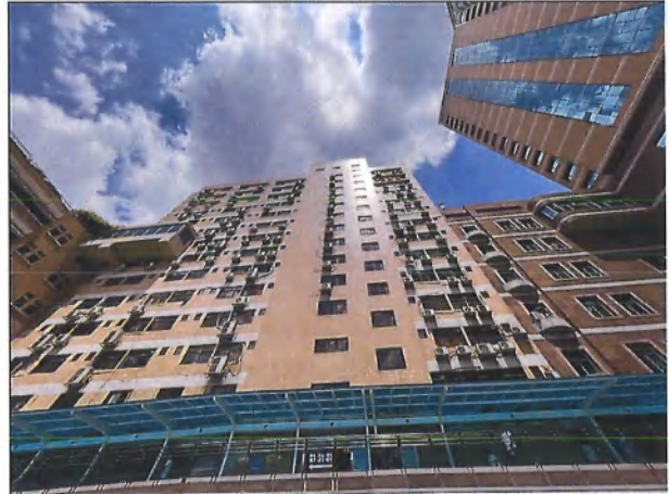
图 1-2 科教楼外立面情况
