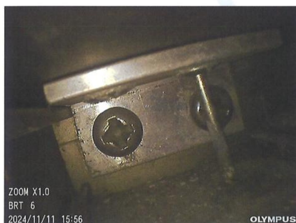
图 5-5 梁柱连接情况 1
