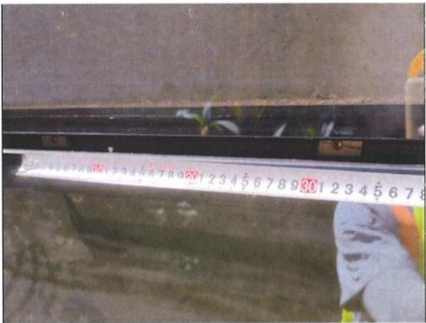
图 5-16 压块设置间距测量
