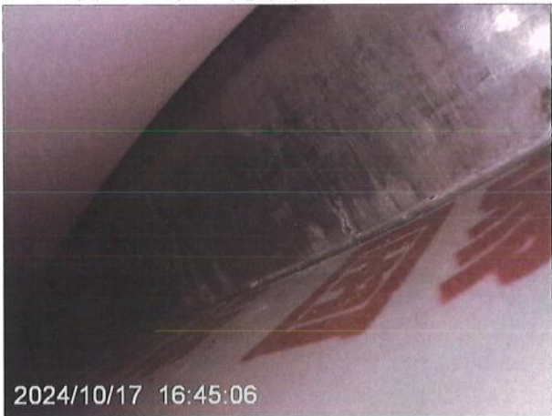
图 4-55 办公楼防火板检查情况 1
