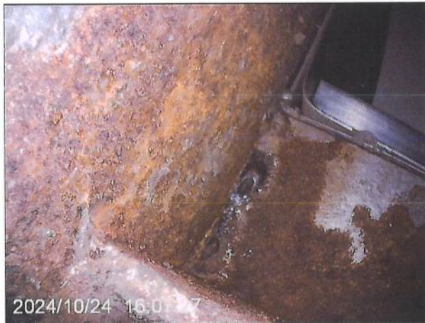
图 7-21 立柱锈蚀
