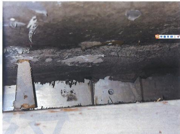
图 4-16 东 1 号楼检查情况 4
