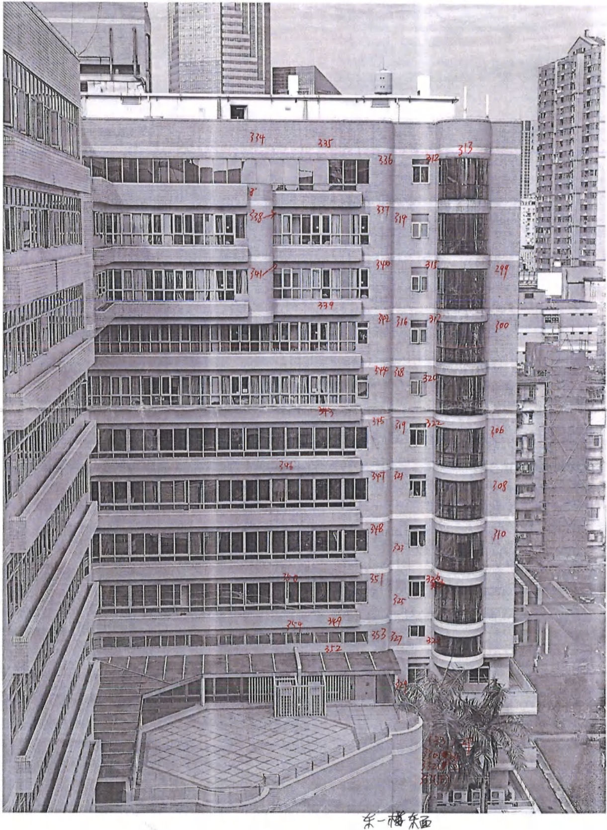
图8-26 东1号楼东面瓷砖缺陷位置示意图
