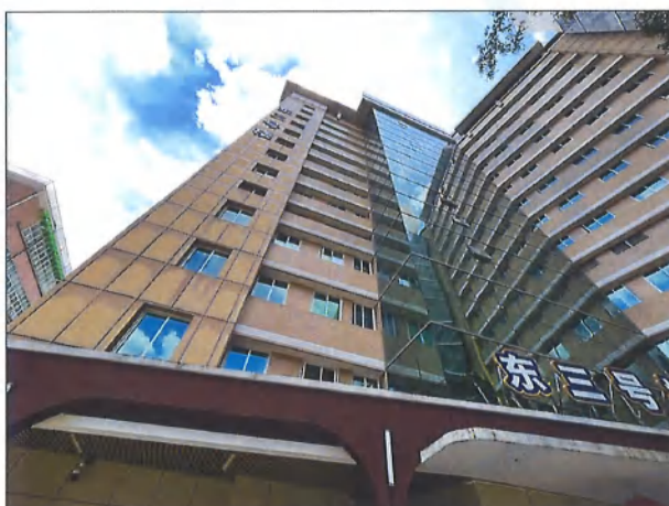
图 1-9 东 3 号楼外立面情况
