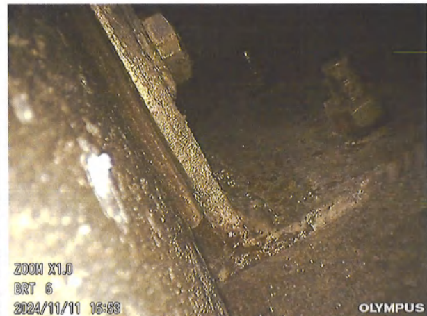
图 5-12 立柱与主体结构连接情况 4
