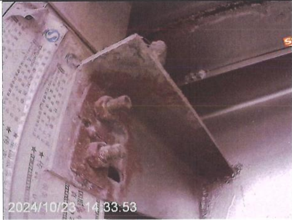
图 4-19 东 2 号楼检查情况
