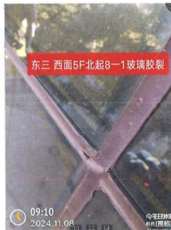
图 10-5 玻璃密封胶开裂
