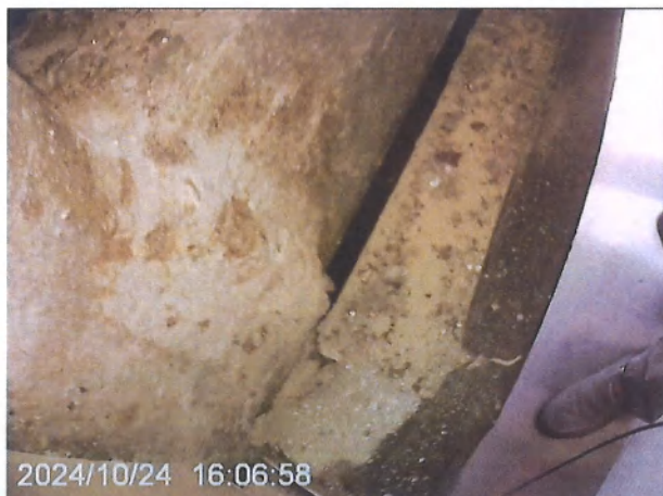
图 7-5 梁柱连接焊缝检查情况 1
