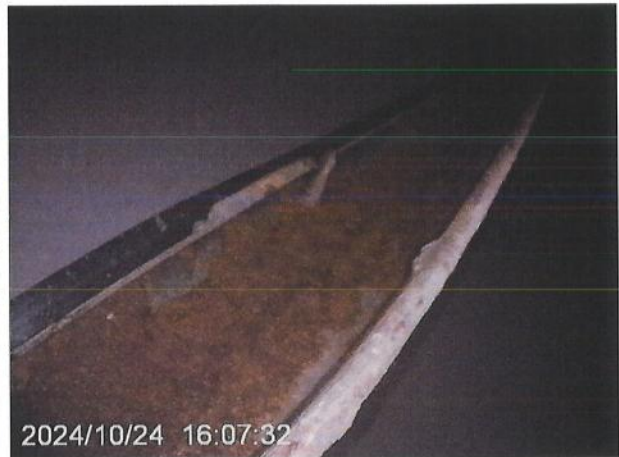
图 7-22 横梁锈蚀
