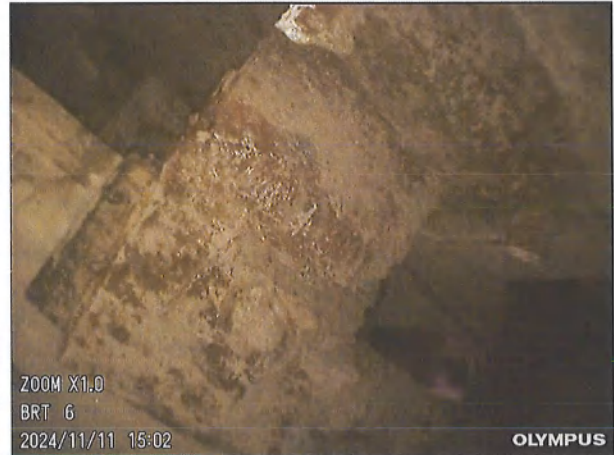
图 5-10 立柱与主体结构连接情况 2 (单颗螺栓)
