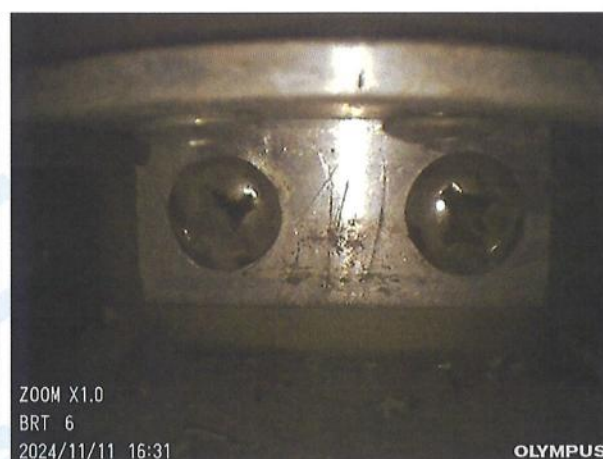
图 5-6 梁柱连接情况 2
