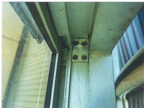
图 4-9 东 1 号楼检查情况
