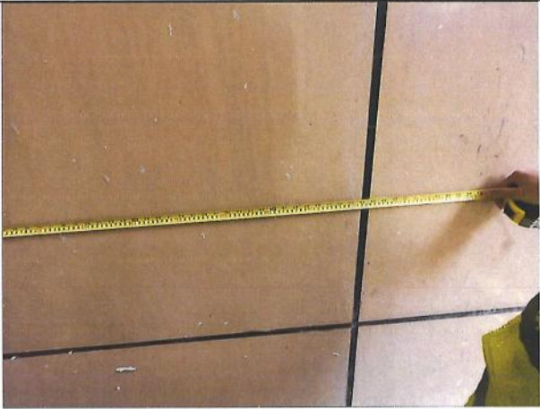
图 7-13 面板分格尺寸检测
