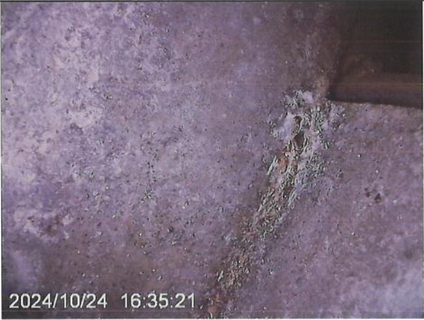
图 7-8 梁柱连接焊缝检查情况 4
