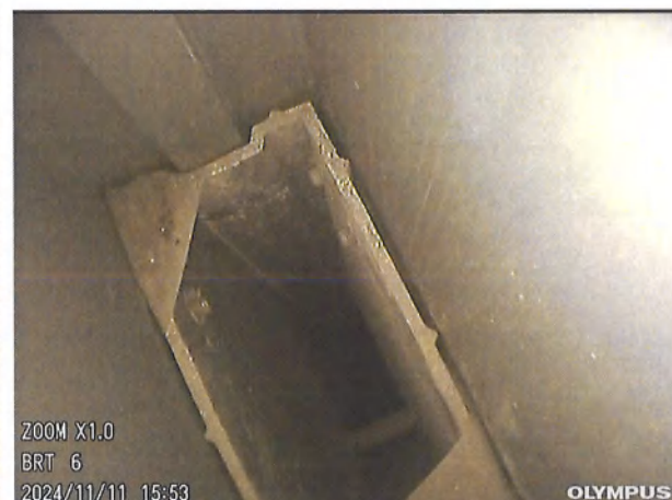
图 5-14 钢立柱套芯检查情况
