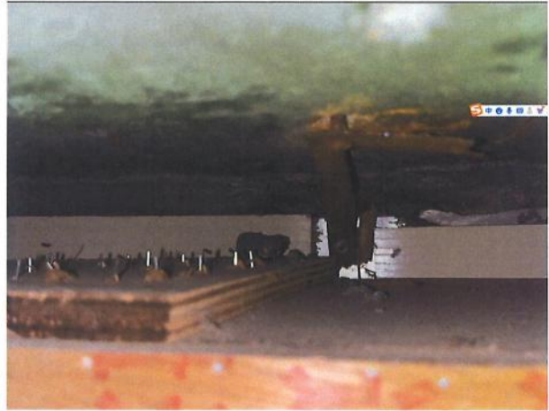
图 4-14 东 1 号楼检查情况 2
