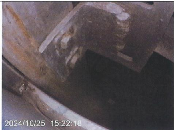
图 7-11 立柱与连接板连接情况 3
