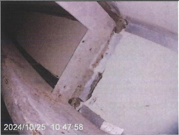
图 7-7 梁柱连接焊缝检查情况 3
