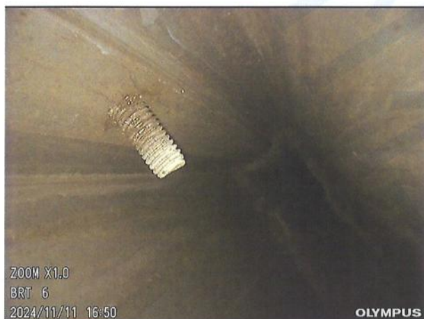
图 5-1 立柱内壁检测情况 1
