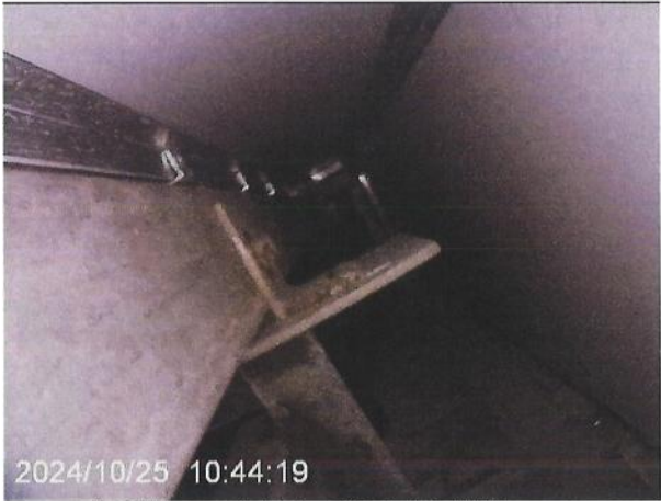
图 7-10 立柱与连接板连接情况 2
