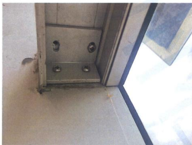
图 4-7 门诊住院大楼检查情况
