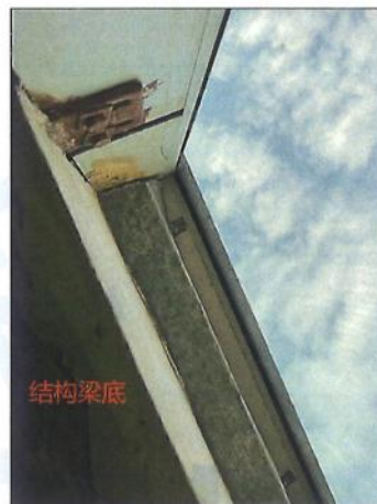
图 4-50 门诊住院大楼防火构造检查情况 2
