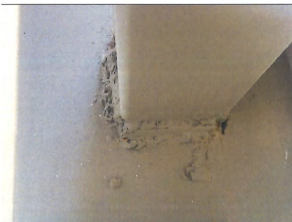
图 6-9 职工餐厅支承构件连接焊缝加塞钢筋
