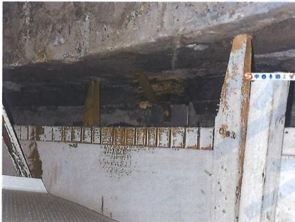
图 4-15 东 1 号楼检查情况 3
