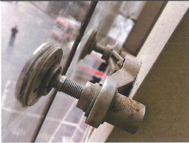
图6-23 嵌装螺母轻微锈蚀
