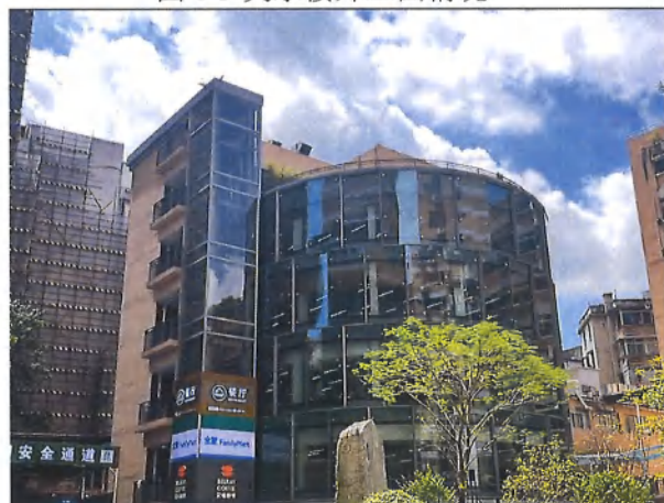
图 1-5 职工餐厅外立面情况
