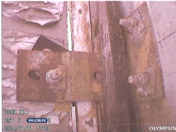
图 5-9 立柱与主体结构连接情况 1 (单颗螺栓)
