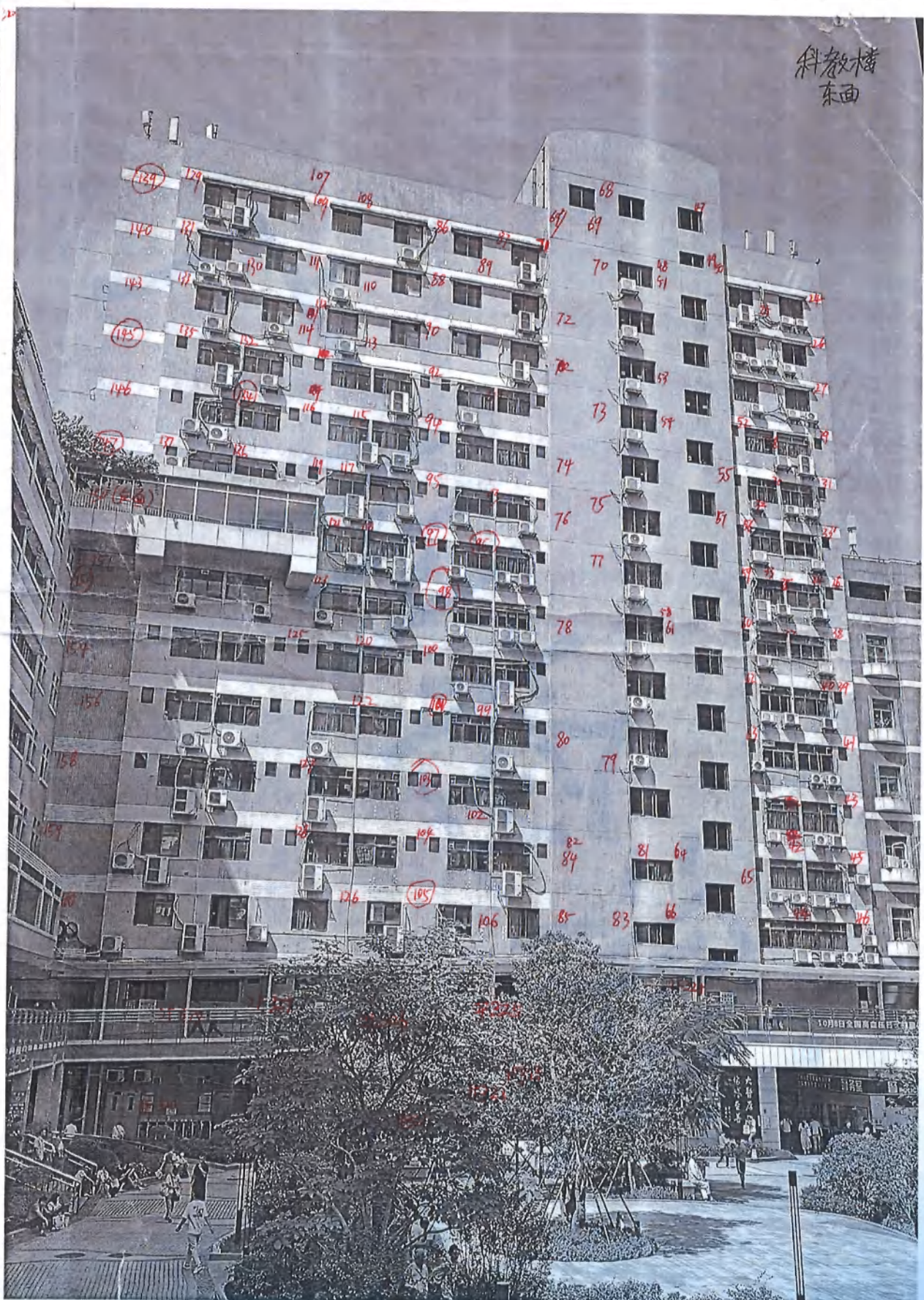
图8-11 科教楼东面瓷砖缺陷位置示意图
