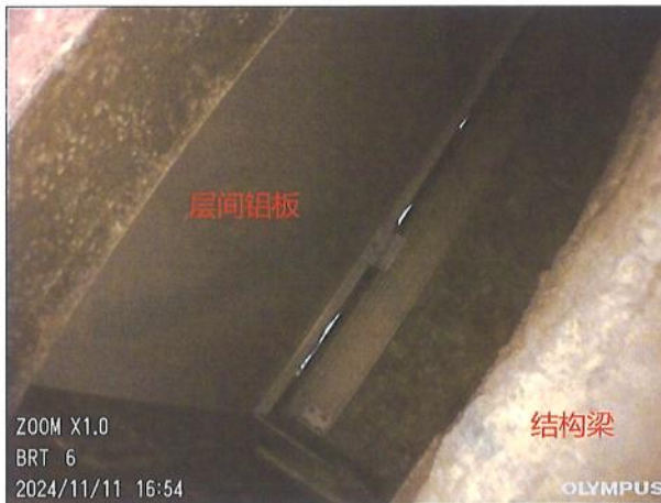
图 5-24 未设置防火构造 1
