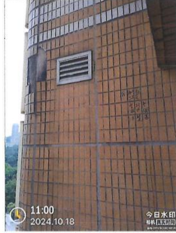
图 8-5 瓷砖空鼓脱落 2
