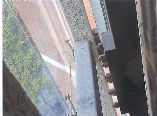
图6-6 门诊住院大楼正门南北侧电梯检查情况2
