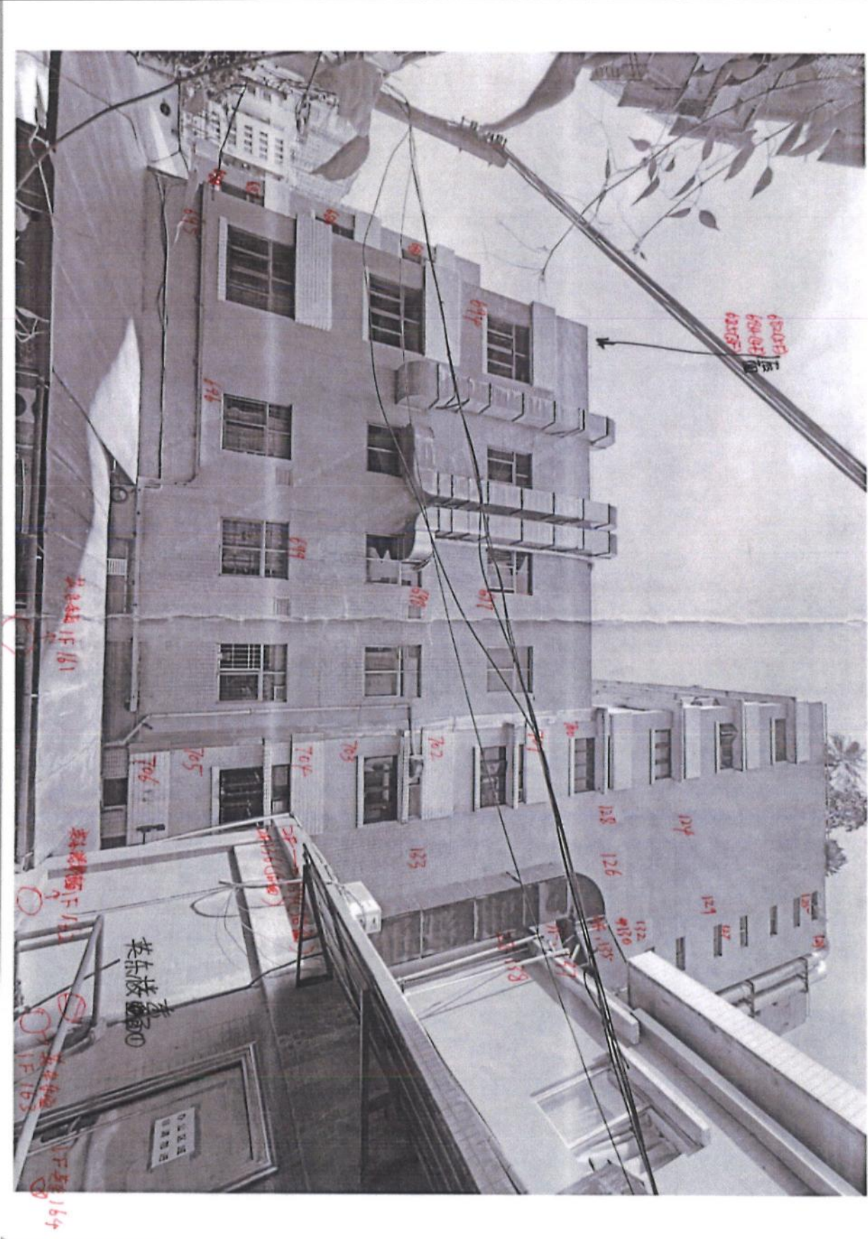
图8-16 英东楼东面1瓷砖缺陷位置示意图
