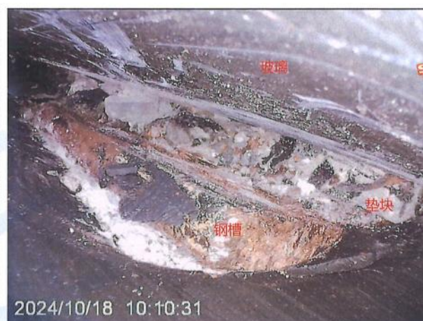
图 4-34 全玻璃幕墙面板底部连接构造
