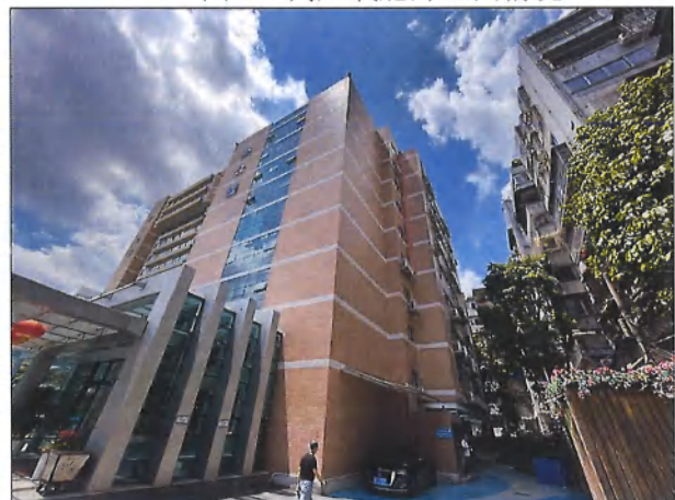
图 1-6 办公楼外立面情况
