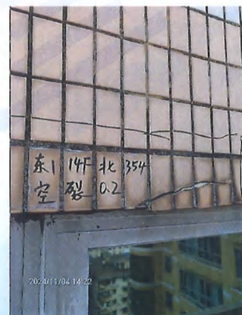
图 8-3 瓷砖空鼓开裂 2
