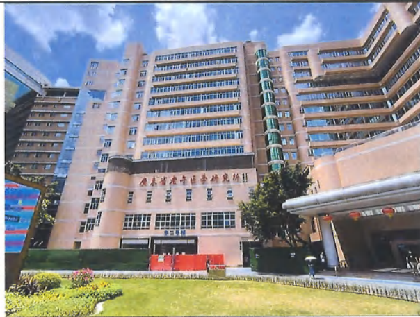
图 1-8 东 2 号楼外立面情况
