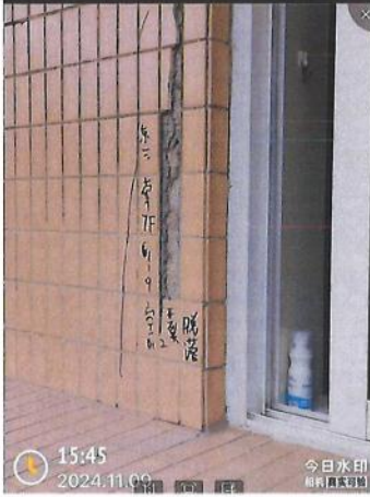
图 8-4 瓷砖空鼓脱落 1
