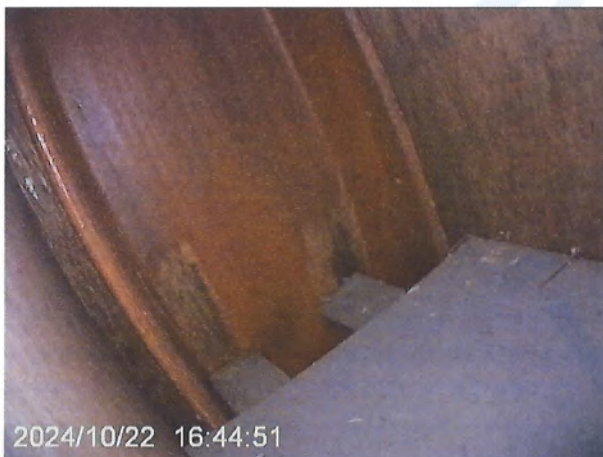
图6-7 门诊住院大楼2F连廊支承构件检查情况
