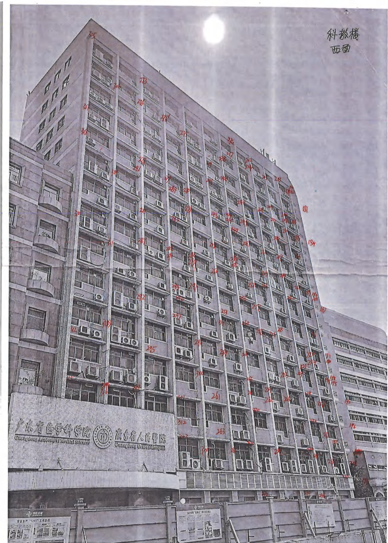
图8-10 科教楼西面瓷砖缺陷位置示意图
