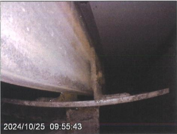
图 7-9 立柱与连接板连接情况 1
