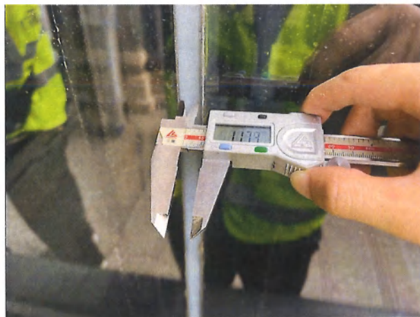
图6-20 玻璃之间的空隙宽度测量2
