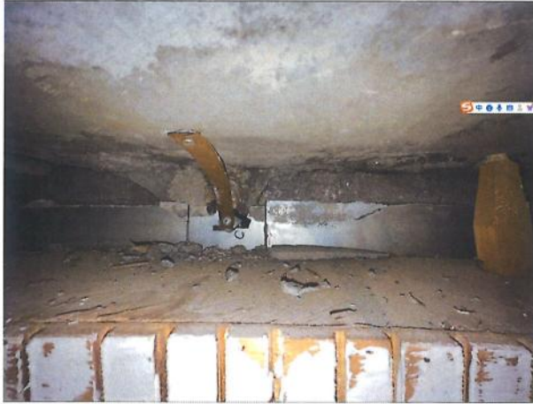
图 4-13 东 1 号楼检查情况 1
