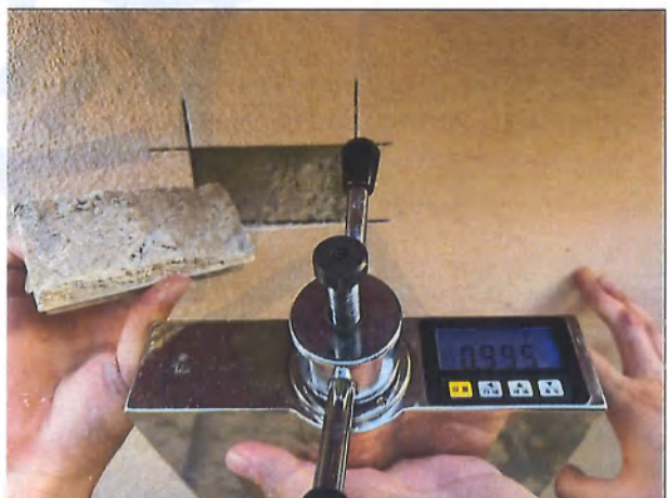
图8-93 抹灰砂浆现场拉伸粘结强度试验情况
